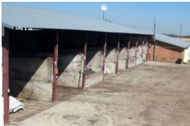
*На биозаводе Кубанского АгроБиоКомплекса применена адаптированная технология подготовки компостов в **биодинамических ферментёрах (аэробункерах)**. При высокой **температуре (65-75° С)**, которая создается в многотонной толще компостируемого субстрата интенсивными **биохимическими реакциями**, происходит **полное уничтожение и деактивация вредной/патогенной микрофлоры и семян сорной растительности в компосте.***
